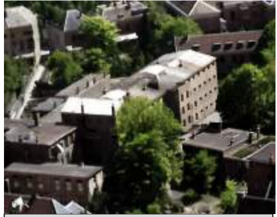
Huis van Bewaring aan het Walburgplein in Arnhem
